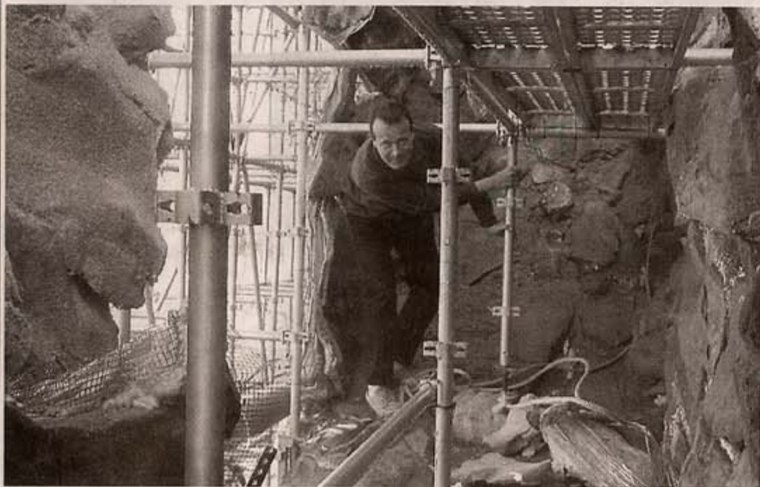
Dominique Charruaud surveille avec un œil attentif les travaux. Chaque jour, cinquante ouvriers s'activent sur le chantier.
